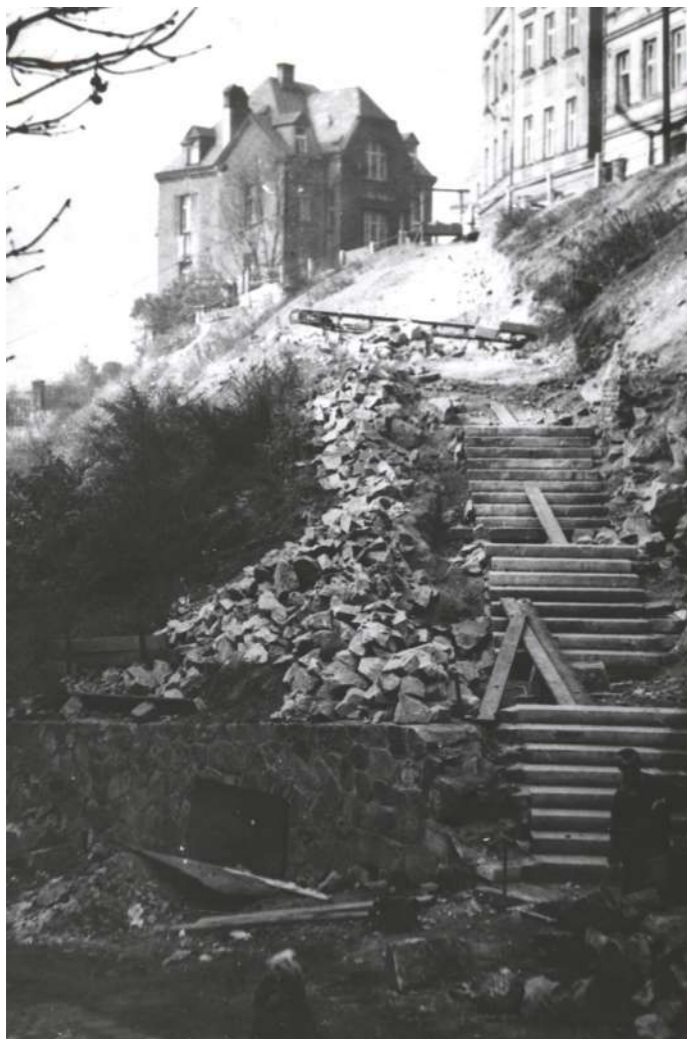
Úprava svahu po demolici v Moravské ulici, vybudování nové opěrní zdi
