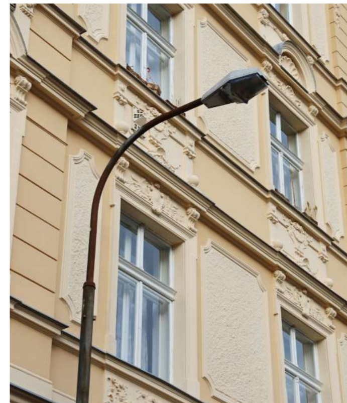
Ulice Petřín, stožárové osvětlení
