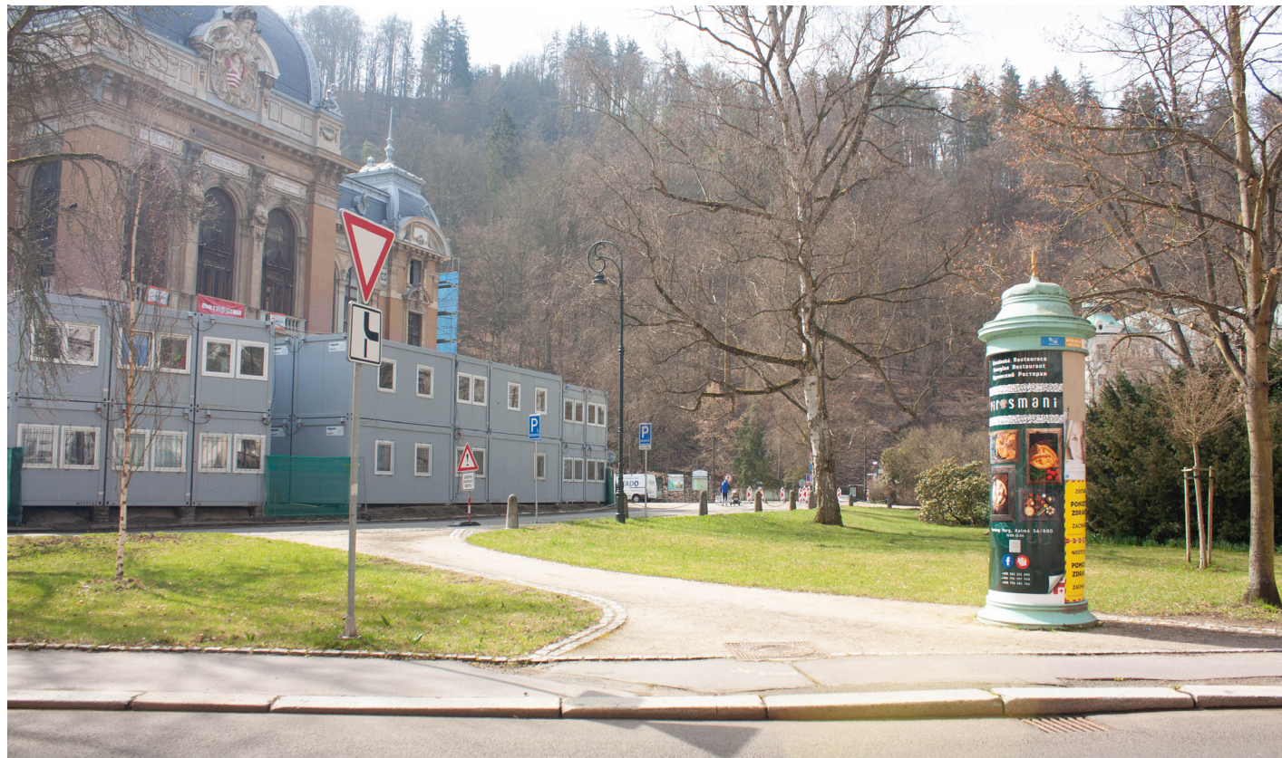
Sady Karla IV. - rekonstrukce Císařských lázní probíhá bez vazeb na okolí
