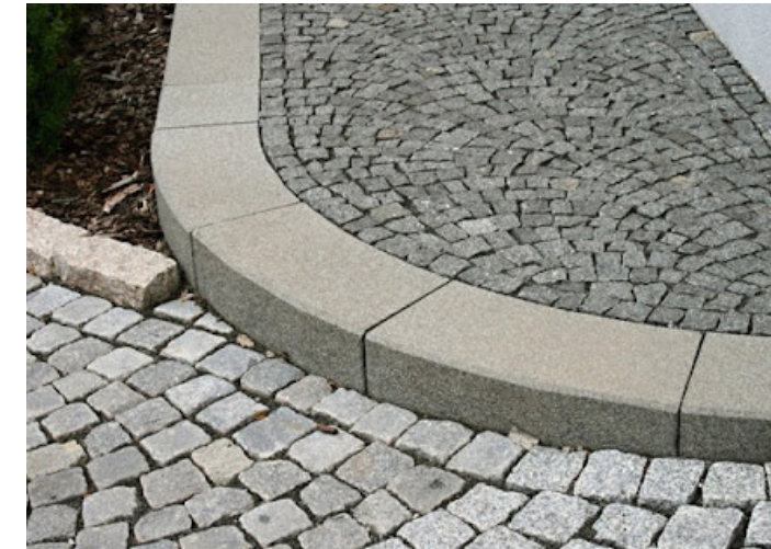
obruba Zóna 30 - Mariánskolázeňská ulice žulový obrubník OP3 25/20, tryskaný povrch, kemenický zámek
