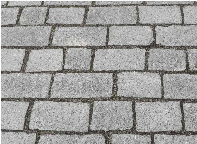
dopravní prostor žulová kostka 16x16-25cm, řezaný povrch, štipaná hrana
