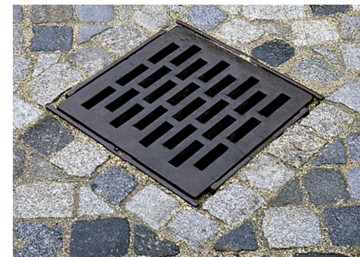
příklad uliční vpusti uliční vpust vždy v úžlabí - obrubě z žulových desek
