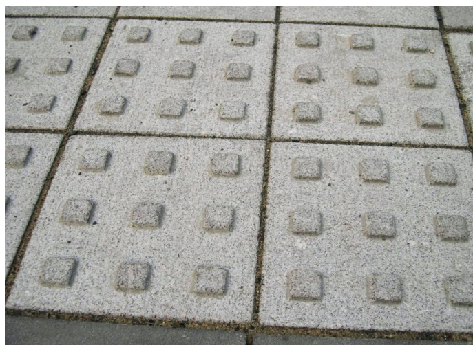
příklad řešení prvků pro nevidomé drážky vodících linií a varovných pruhů frézovány do kamene
