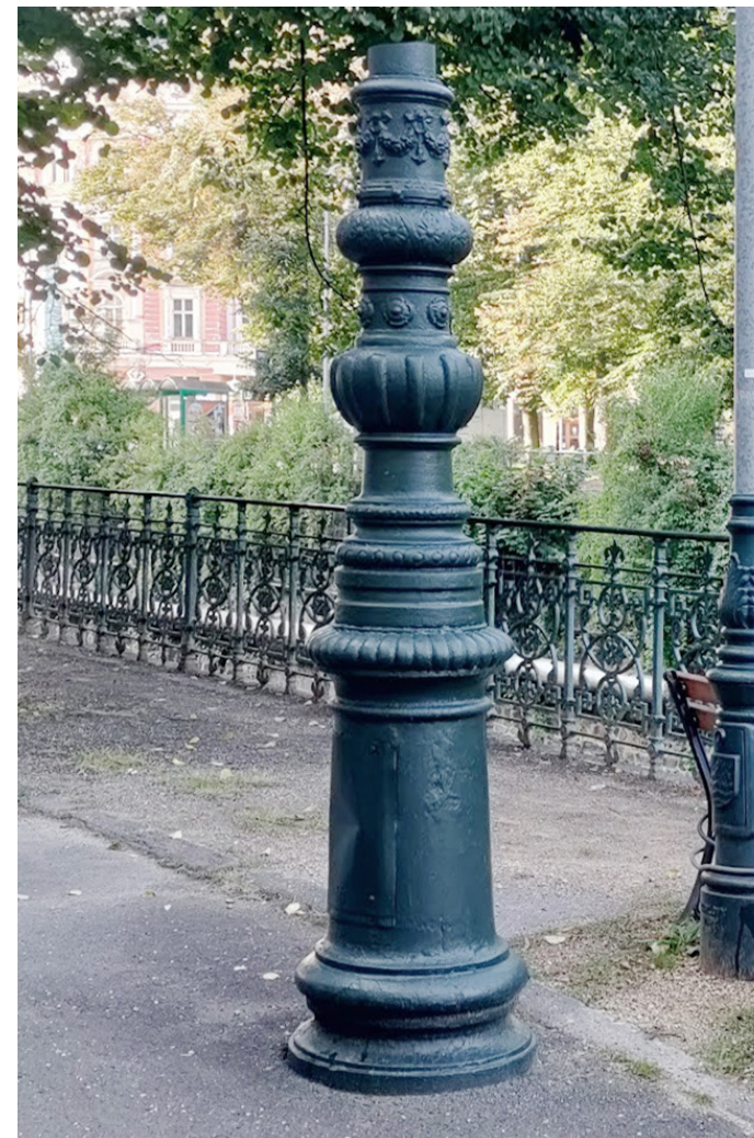
Zachovaný litinový dřík lampy veřejného osvětlení na nábřeží J.Palacha - vzor pro výrobu atypických lamp
