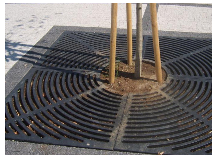
příklad mříže ke stromům litinové dílce, zapuštěné v dlažbě
