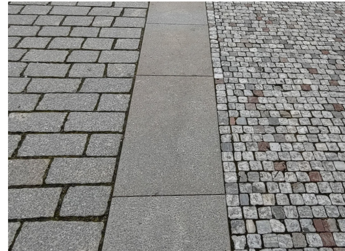
obruba sdílený prostor - slouží jako úžlabí žulové desky š. 50 cm, d. 80-100 cm, tl.12 cm, tryskaný povrch
