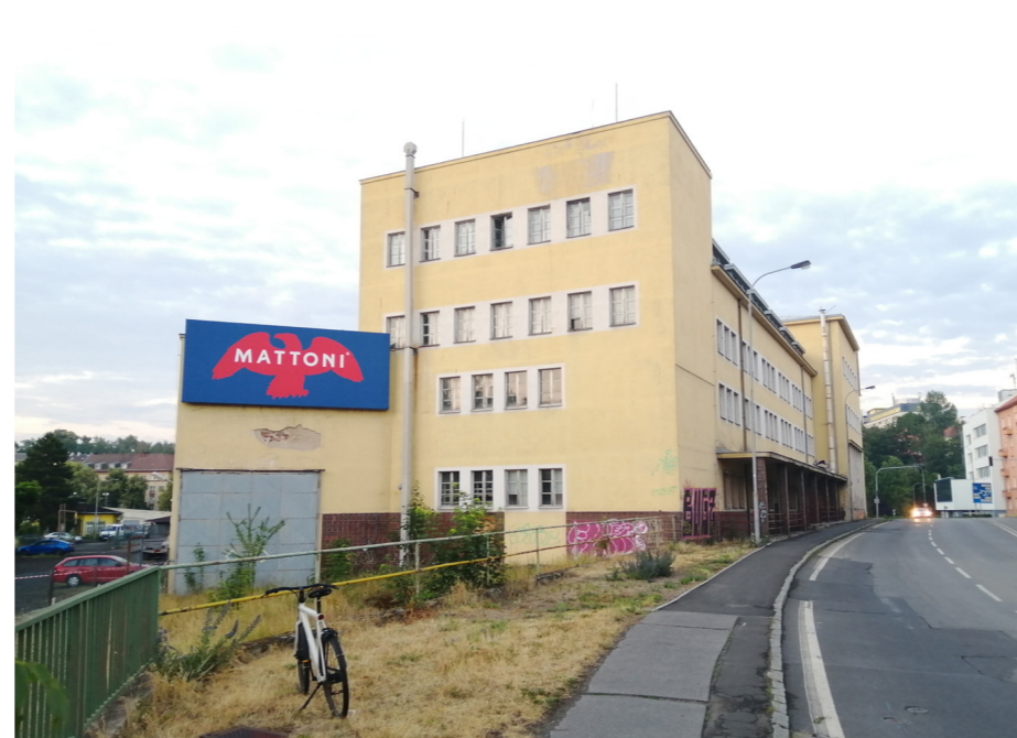
Bývalá stáčírna minerálních vod
