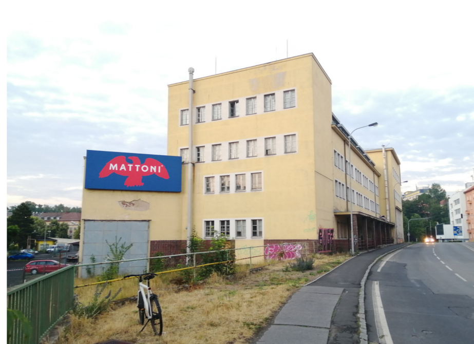
Bývalá stáčírna minerálních vod
