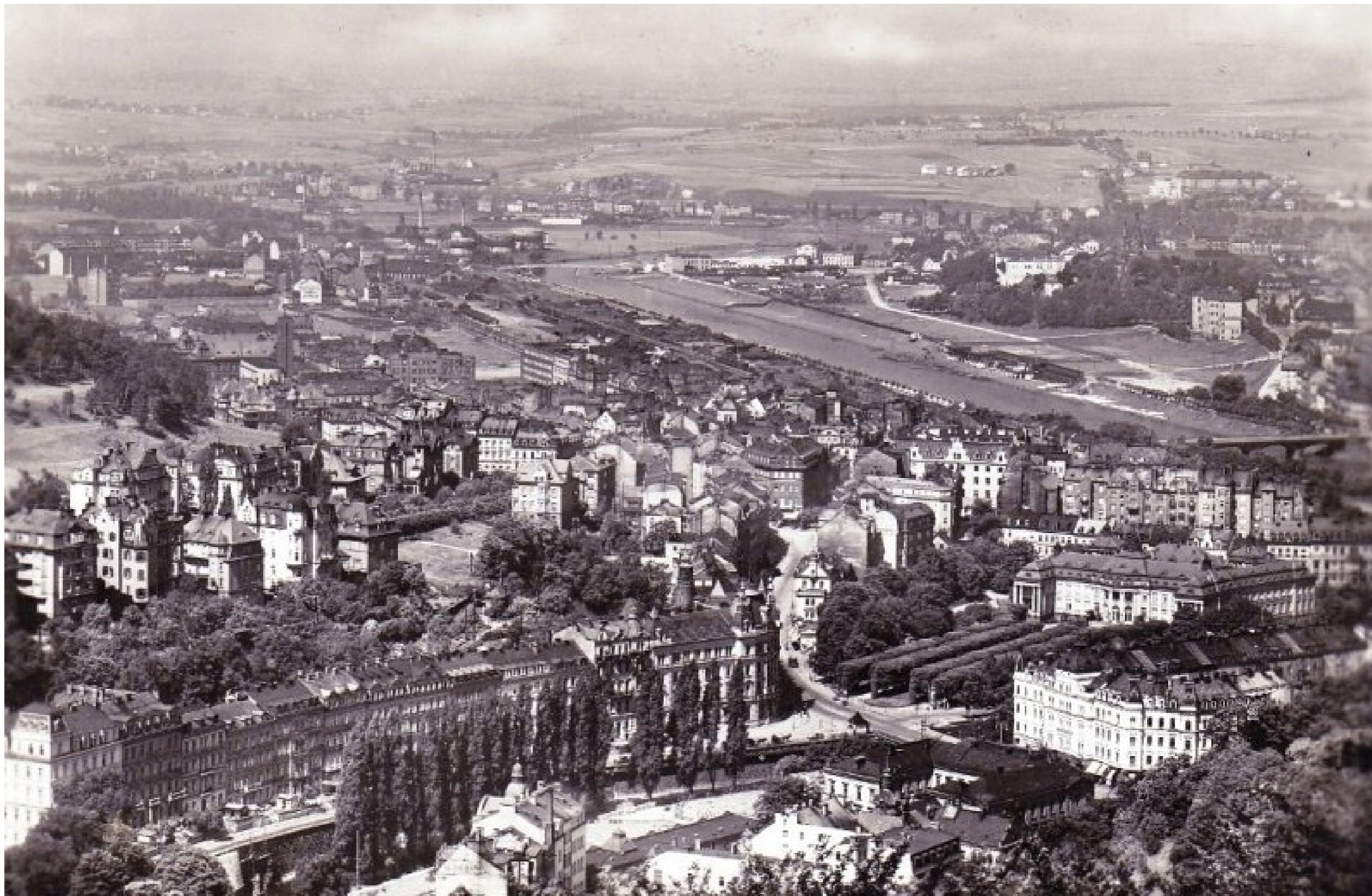
Panoramatický pohled na obchodně správní část města a městskou část Tuhnice - přelom 30. - 40. let 20. století
