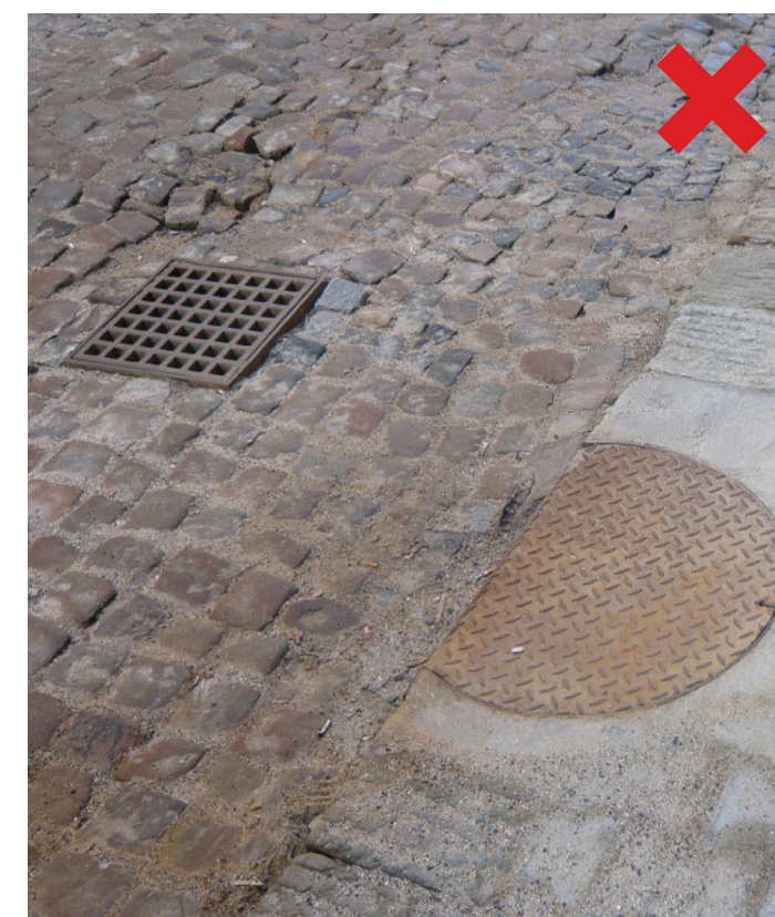
Obr. 5 Nejednotné řešení uličních vpustí Odvodnění řešit středovým žlabem a vpustí ve středu vozovky
