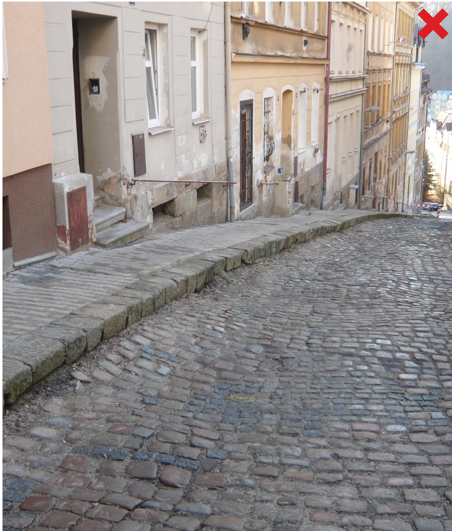
Obr. 1 Nevyhovující uliční profil s příliš vysokým chodníkem, materiálová nejednotnost, domovní vstupy nenavazující na chodník Obrubník řešit max. 100mm vysoký, sjednotit materiály - výchozím bude stávající kamenná dlažba vozovky.
