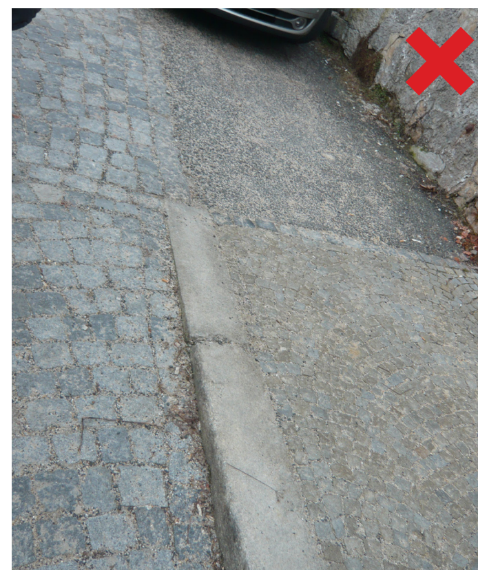
Obr. 4 Materiálová nejednotnost povrchů
