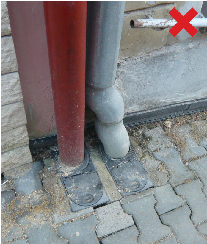
Obr. 9 Nejednotný a nevhodný detail okapního svodu
