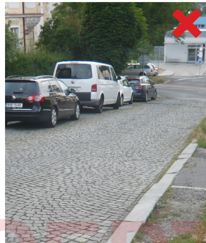
Obr. 8 Nejednotný materiál povrchu vozovky
