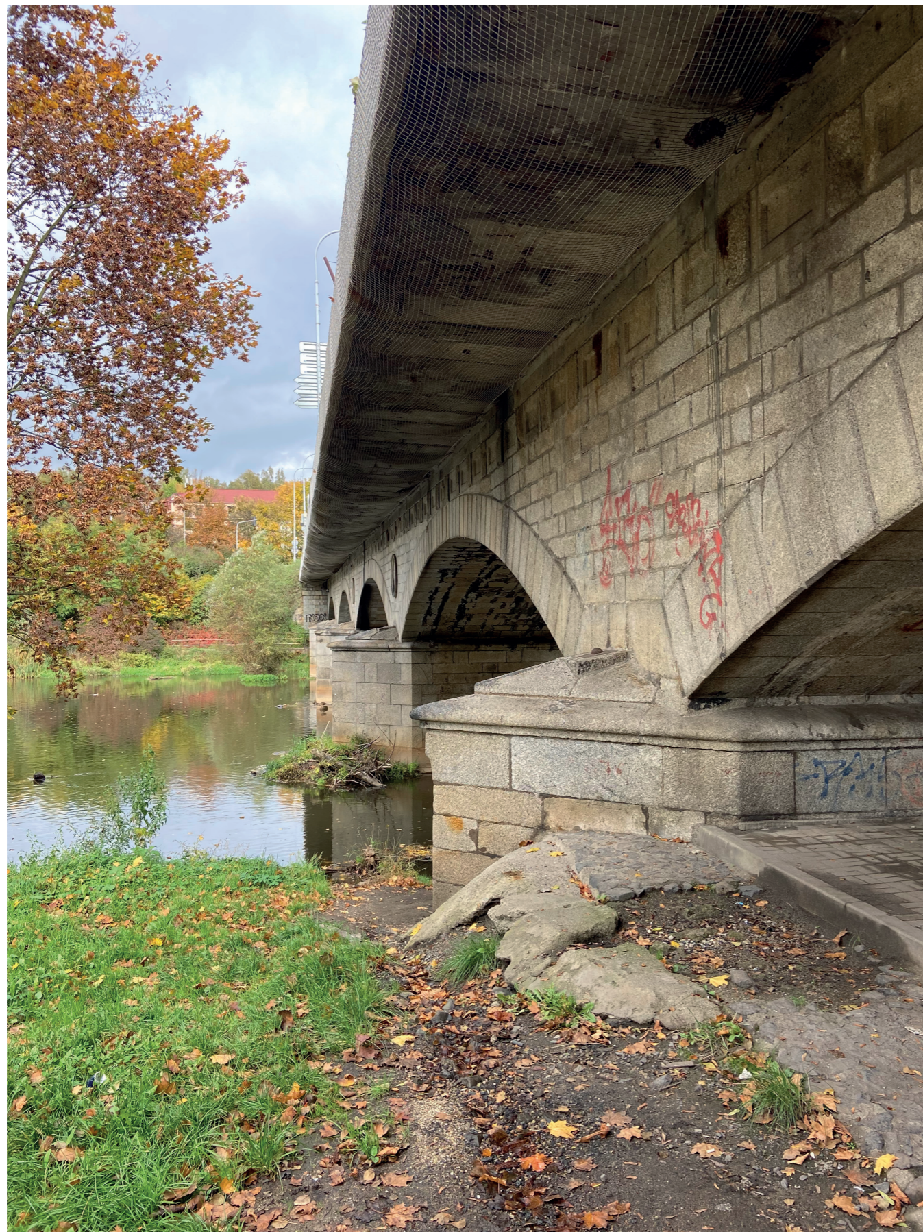
stávající stav mostu po druhém rozšíření chodníkových konzol, 1984–1985
