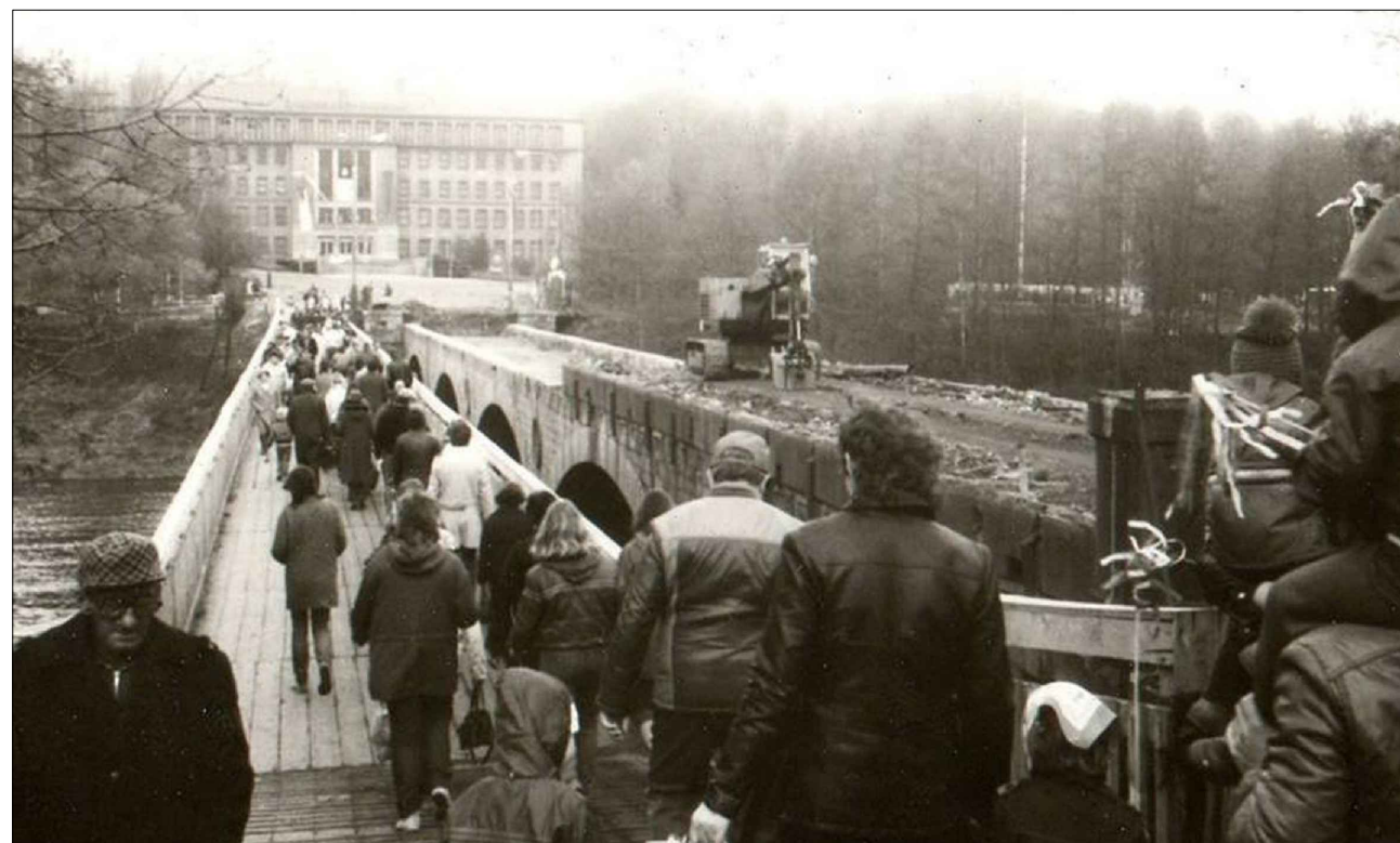
REKONSTRUKCE MOST V 80. LETECH 20. STOLETÍ
