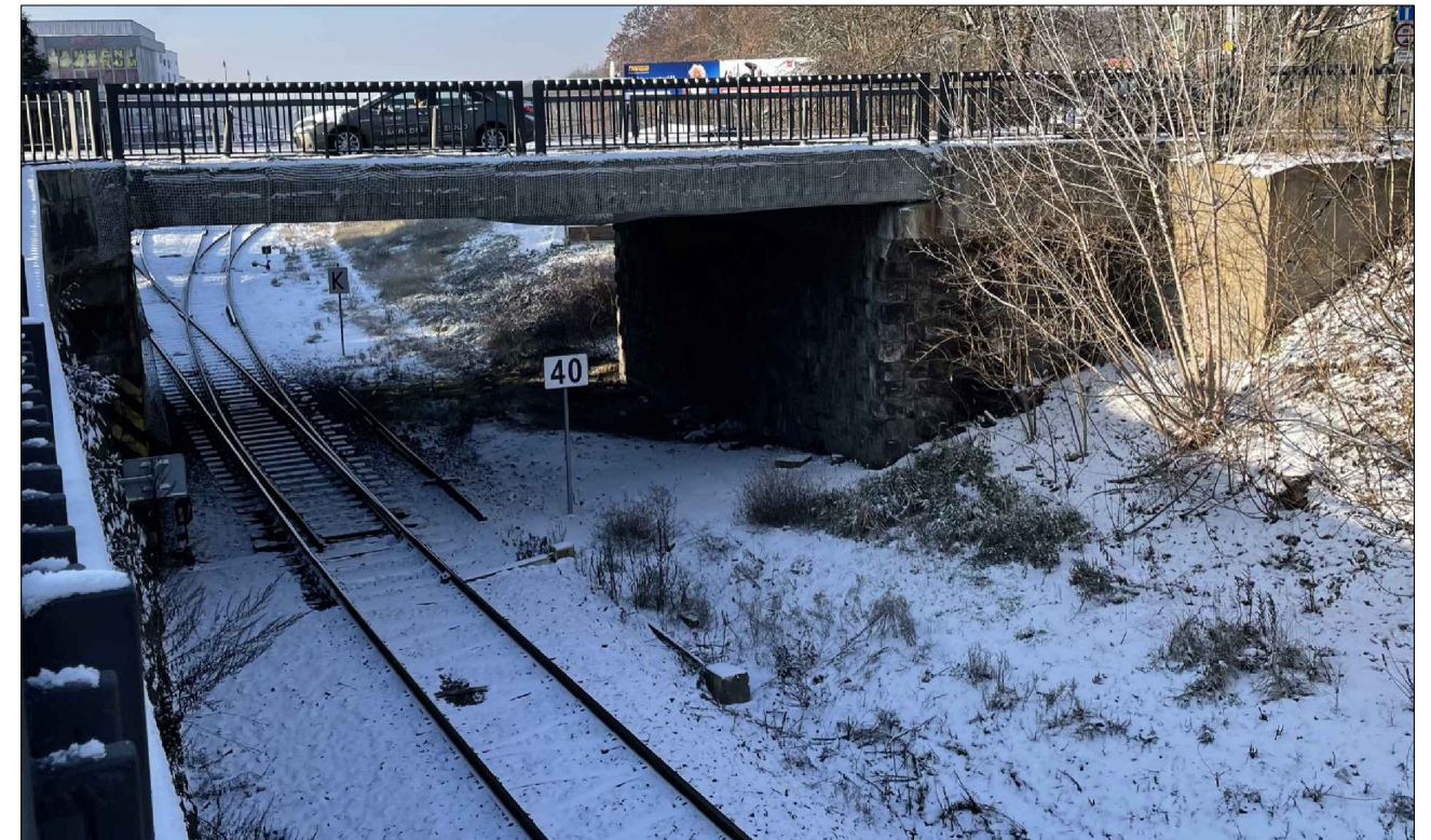
POHLED NA MOST PŘES ŽELEZNICI
