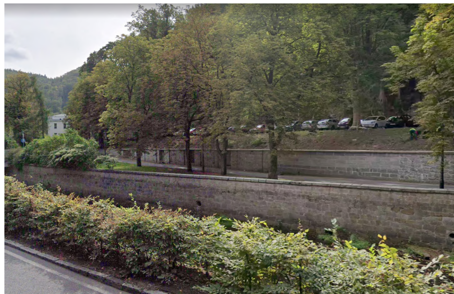
pohled na parkoviště z ulice Slovenská
