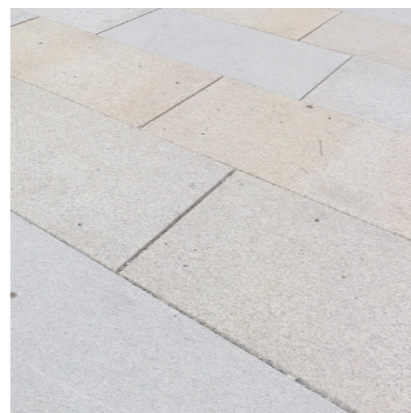
Propojovací komunikace kolem filtrů z dlažby.
