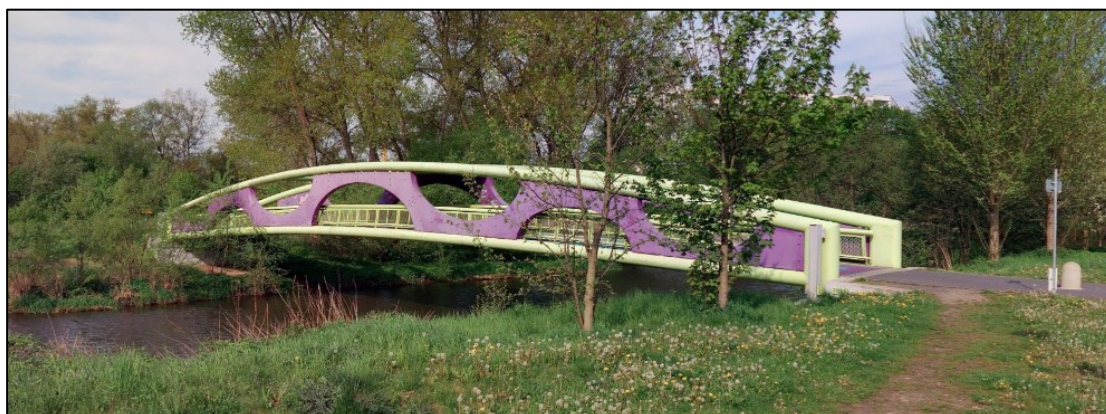
obr. 2-4: Pohled na zvedací lávku, zdroj © Seznam.cz, a.s., Cyclomedia Technology B.V.
