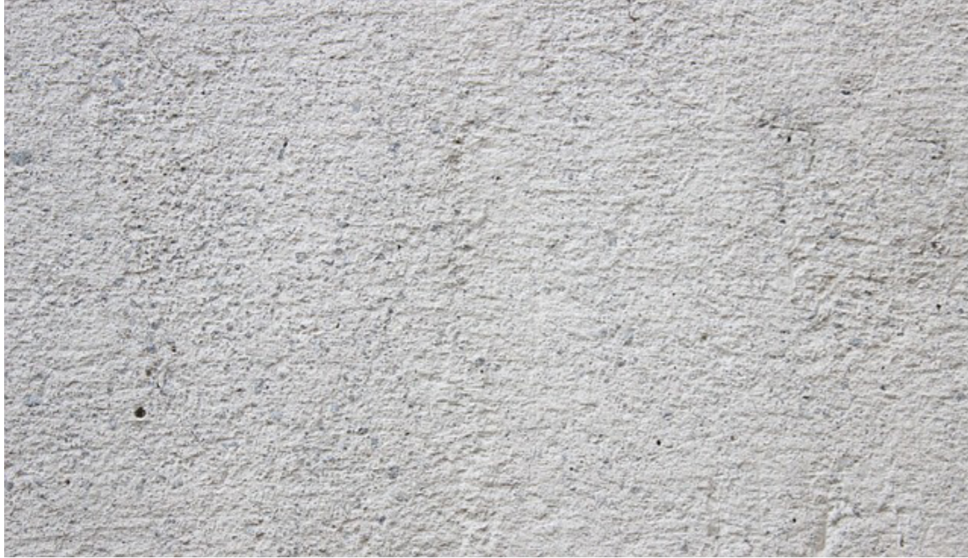
ZASTÁVKOVÝ PRUH: Prefabrikované betonové panely
