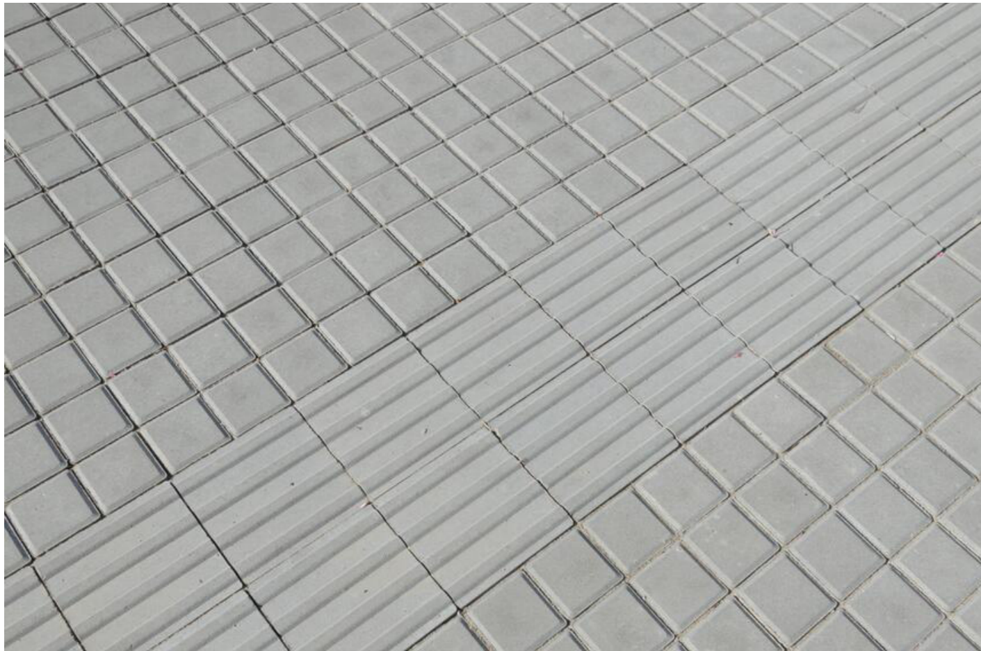
ZASTÁVKOVÉ NÁSTUPIŠTĚ: Betonová zámková dlažba s varovným pásem
