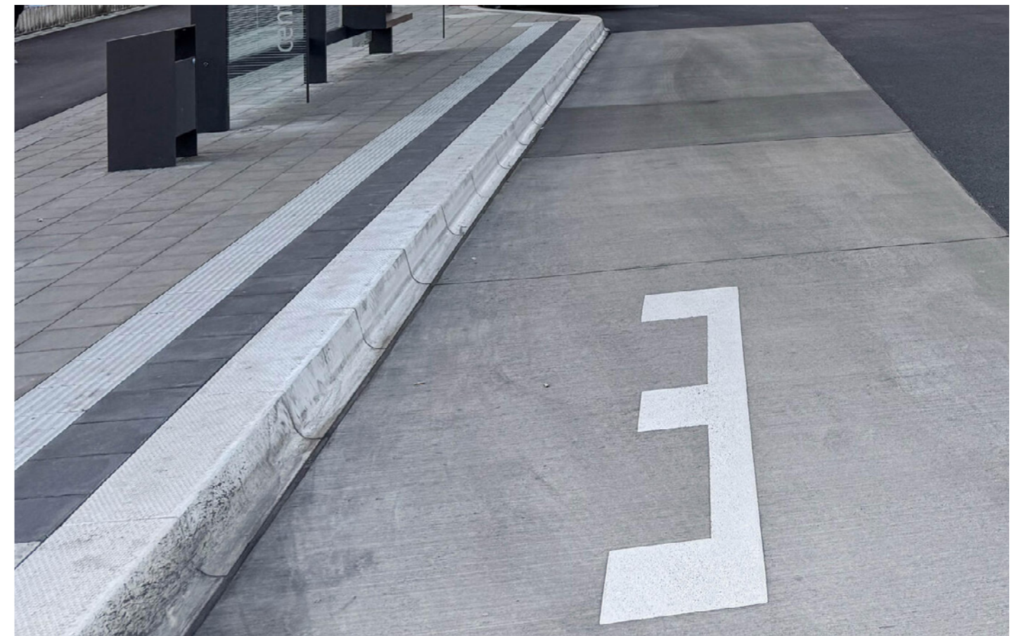
Kombinace betonového povrchu v místě zastavení autobusu s dlažbou na nástupní ploše a betonovým obrubníkem.
