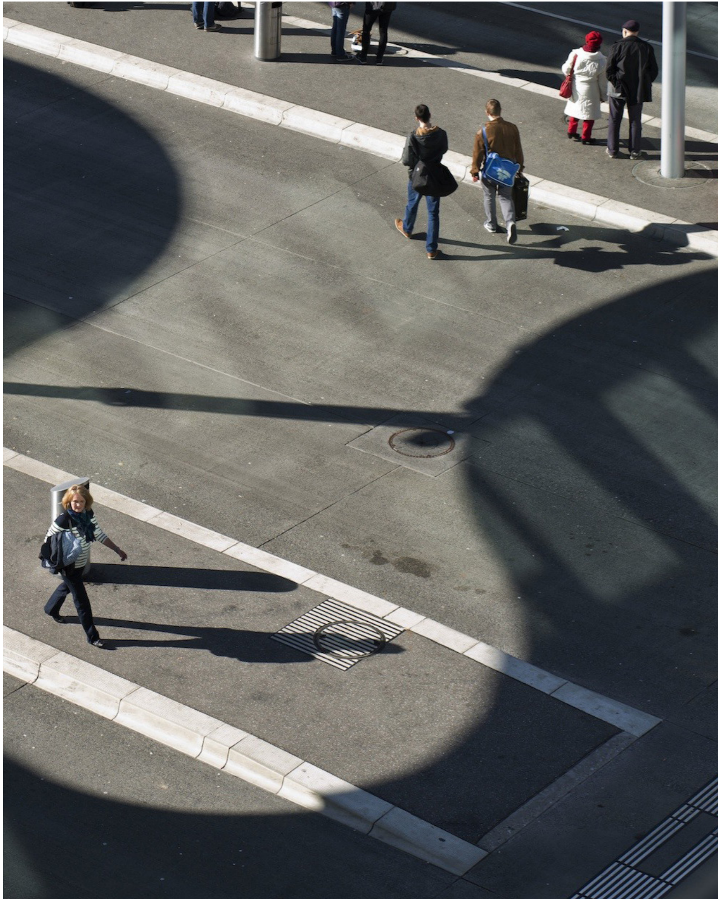
Kombinace asfaltu na nástupních plochách a chodnících s betonem na pojízdné části zastávky s betonovým obrubníkem.
