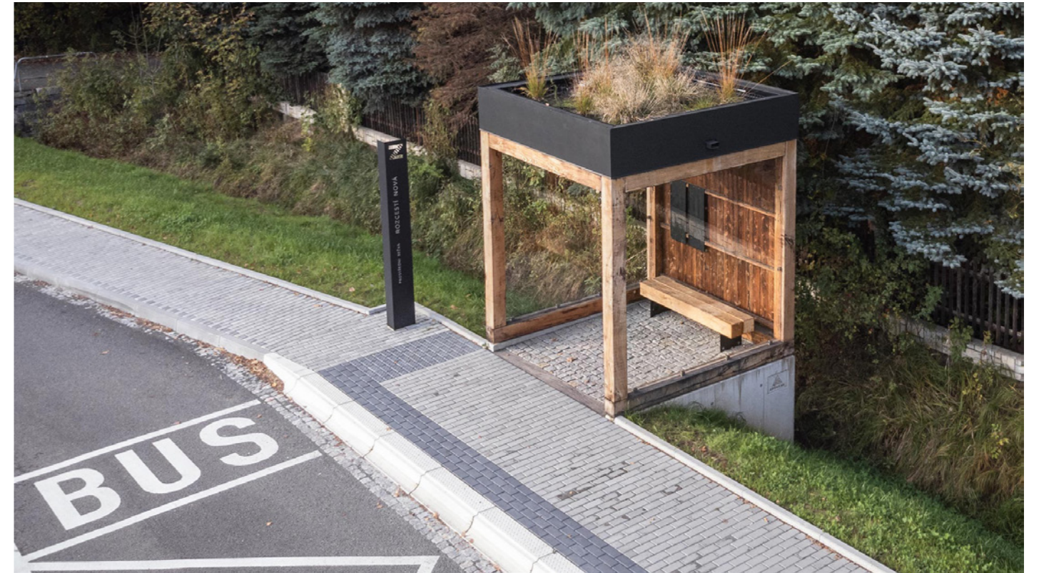
Kombinace asfaltu na pojízdné ploše a dlažby na nástupní ploše (chodníku) s betonovým obrubníkem.
